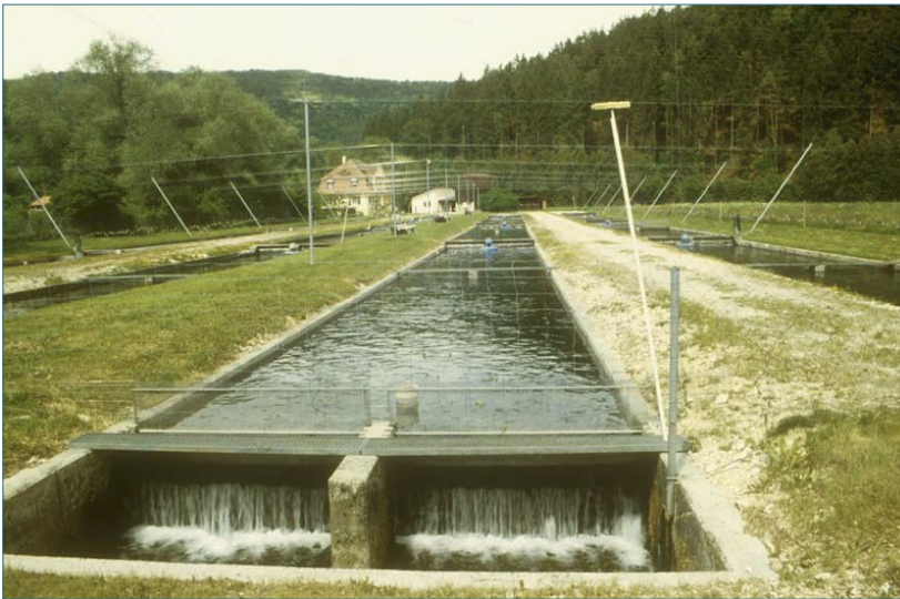
Abb. 110: Fließkanal zur Forellenhaltung [134]
